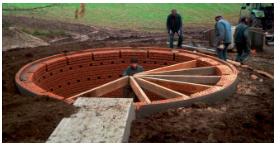
Nieuwbouw voor vleermuizen. Foto Rudi Vantorre
