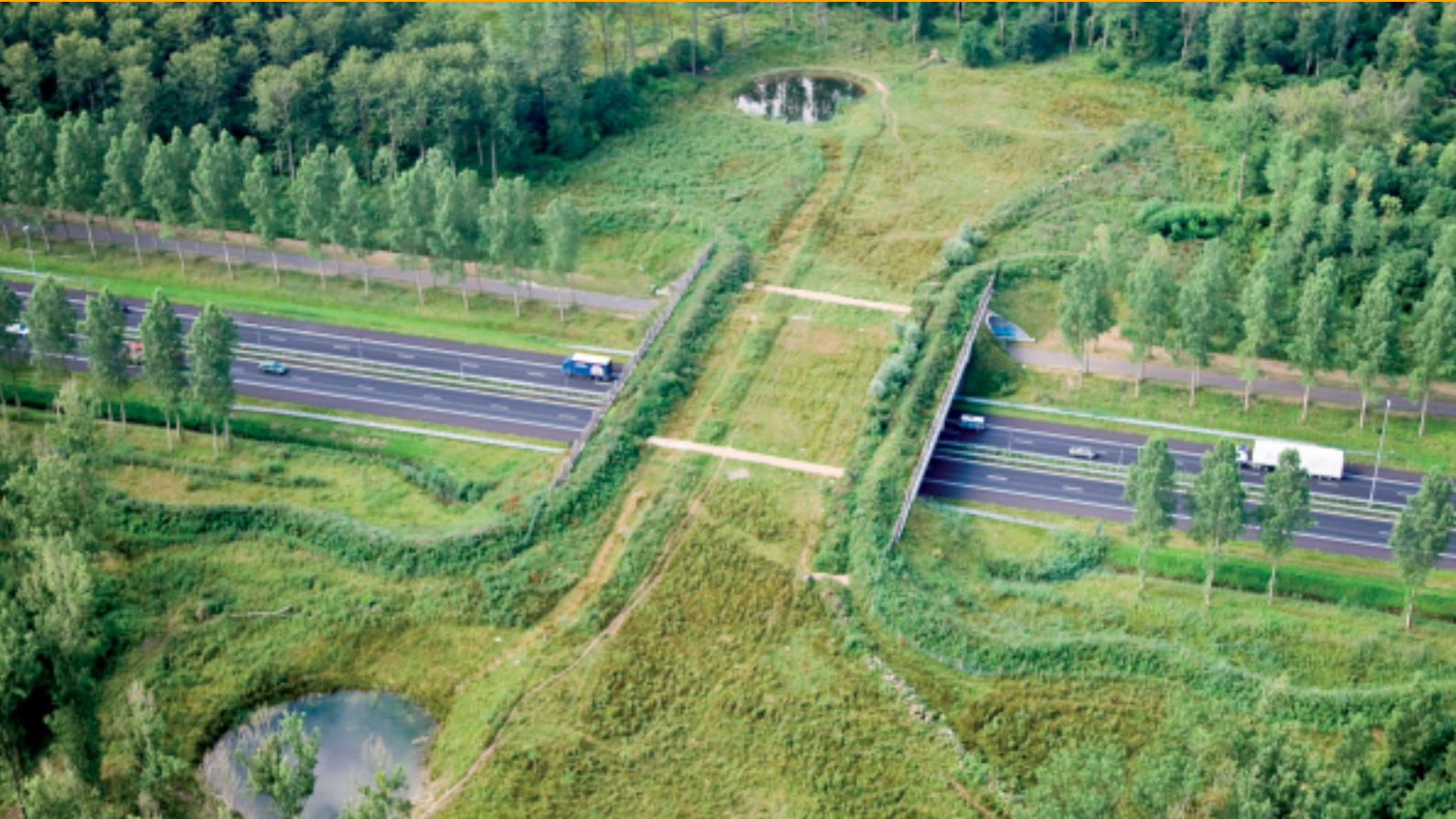
Ecoduct het Groene Woud over Rijksweg A2. Foto:RWS
