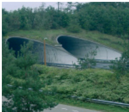
Wildviaduct De Woeste Hoeve. Foto Edgar van der Grift
