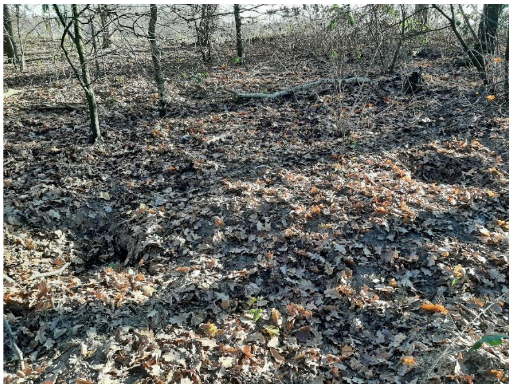
Figuur 3.24: Verlaten dassenburcht bij sluis Hintam dijkpaal WR1.
