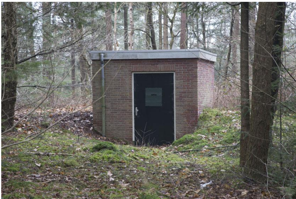
Afbeelding 1: Toegangshuisje. Access to the bat cellar. (Theo Douma)
