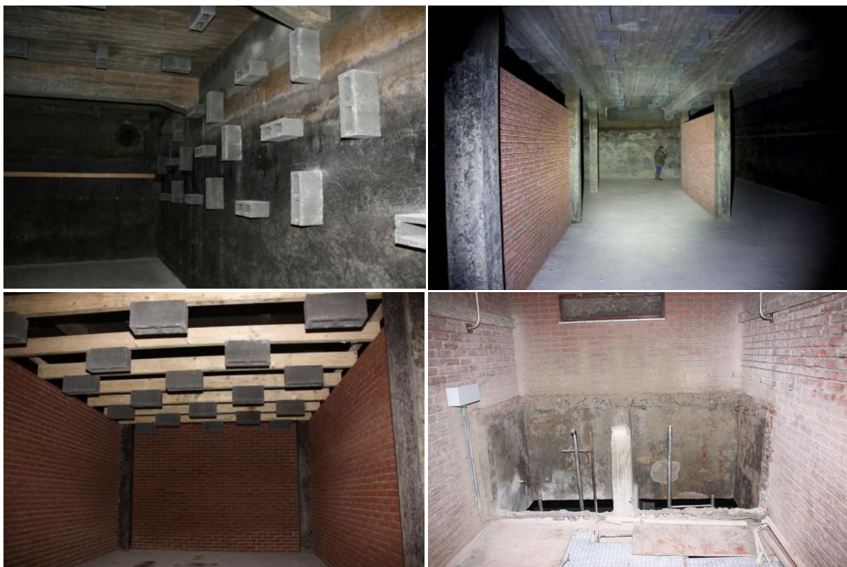
Afbeelding 2: Het interieur van de vleermuiskelders. Inside the bat cellar. (Theo Douma)
