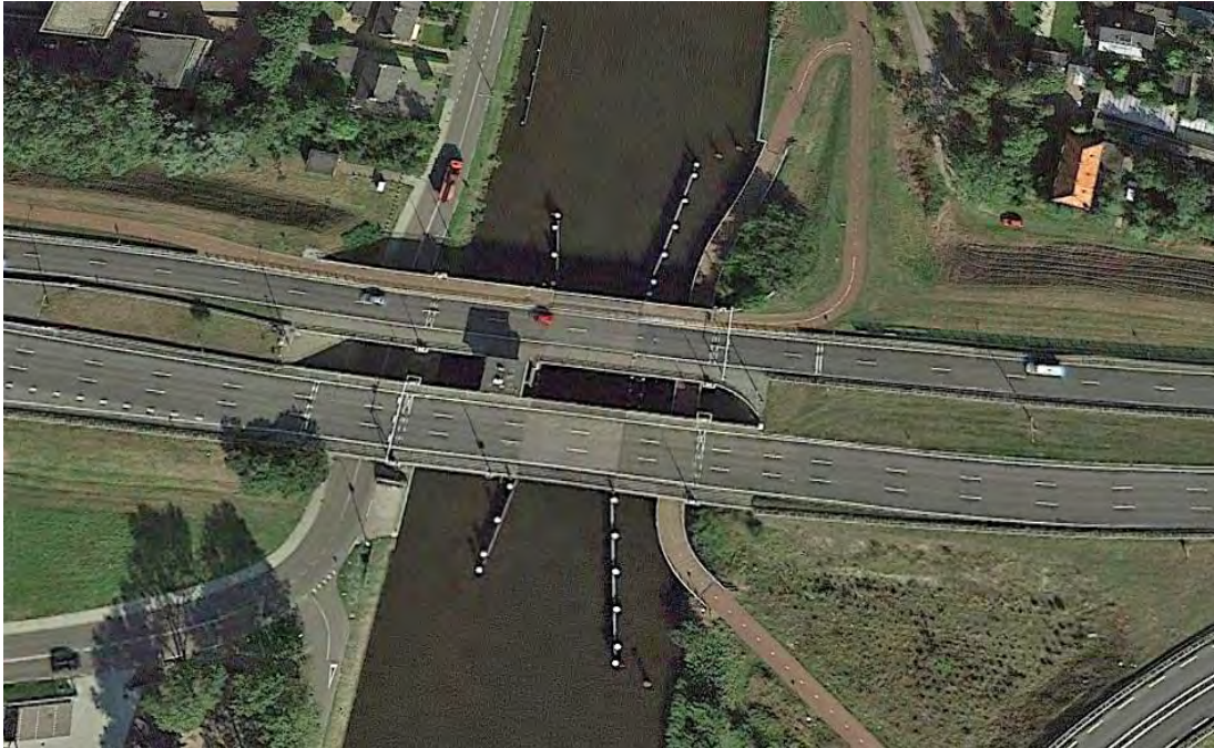
Figuur 1: Leeghwaterbrug. Aan de westzijde (linkerkant op de foto) is een onderdoorgang voor de ventweg, aan de oostzijde een fietstunnel. Luchtfoto: © Google Earth.
