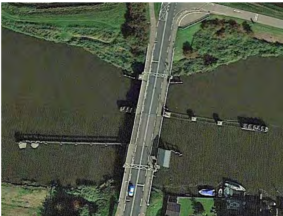
Figuur 7: Beatrixbrug bij West-Knollendam. Luchtfoto: © Google Earth
