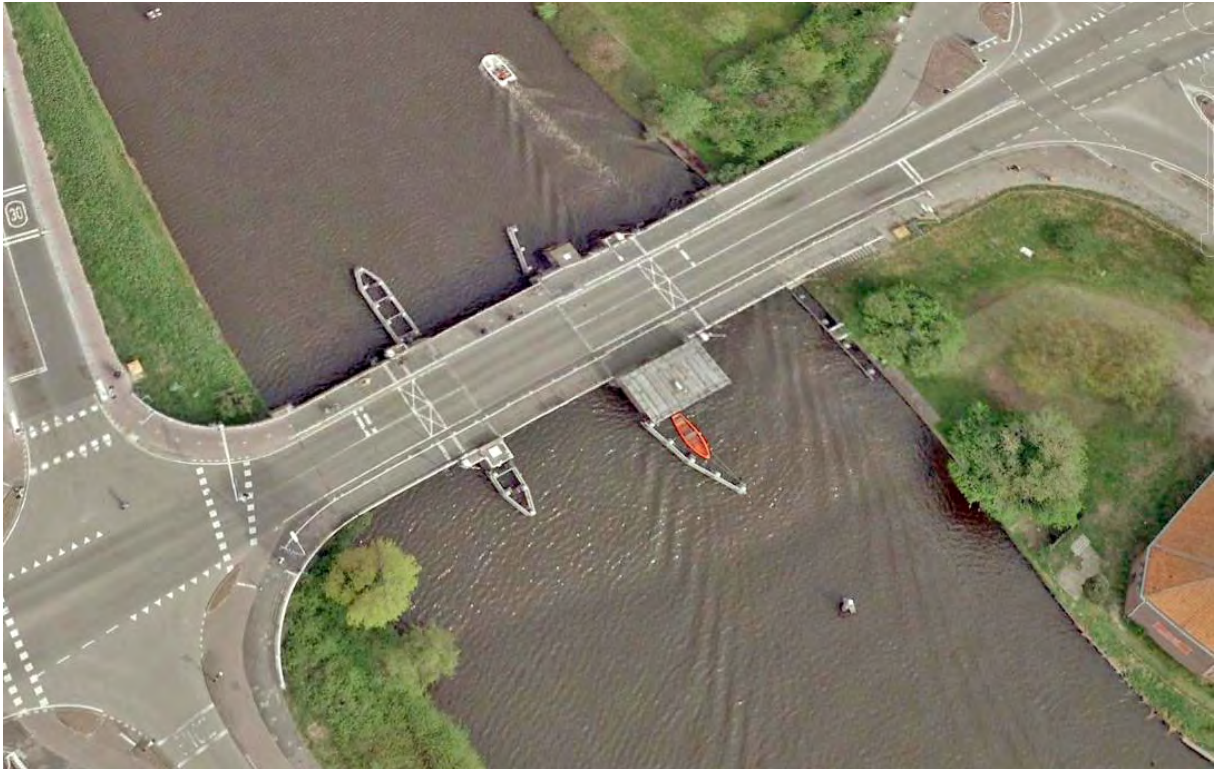
Figuur 16: Brug N255 over de Amstel bij Ouderkerk aan de Amstel Luchtfoto: © Google Earth.
