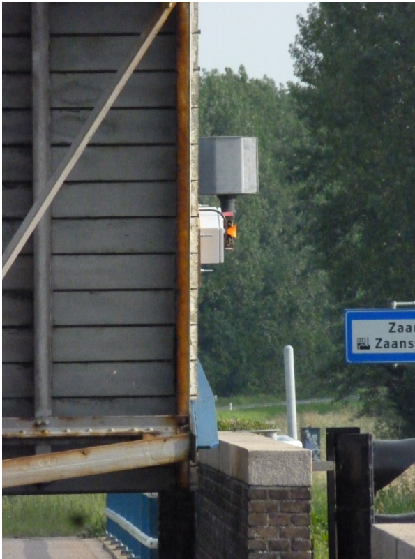
Figuur 14: Bevestiging aan de brugleuning. Ook wanneer de brug opengaat blijft de constructie op zijn plaats.
