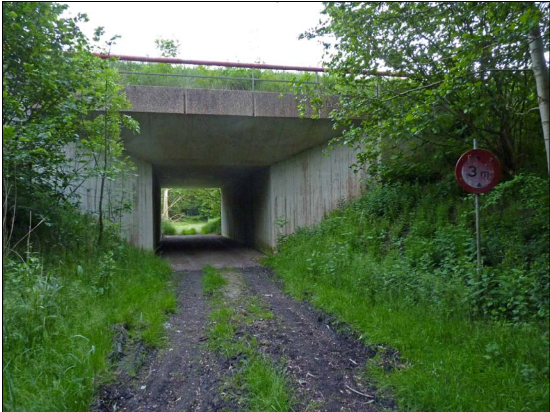
Afbeelding 3. Dit tunneltje onder de spoorlijn Lelystad - Almere vormt voor vleermuizen een geschikt punt om van de ene kant van het spoor naar de andere kant te vliegen. In het tunneltje is tijdens het onderzoek tweemaal met behulp van een onbemande batdetector bekeken welke soorten vleermuizen van het tunneltje gebruik maken.
