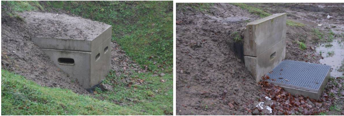
Figuur 1: De zuid en de noord vleermuistoegang tot de nieuwe vleermuiskelder in de nieuw aangeaarde situatie van 2011. Onder de noordzijde bevindt zich de pompput.
