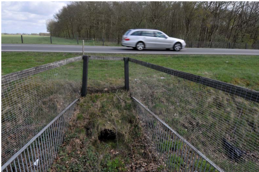
Figuur 6. Dassentunnel bij locatie 1 Oosterveld. Deze tunnel wordt niet gebruikt door dassen. (Foto: Monique Achterberg).
