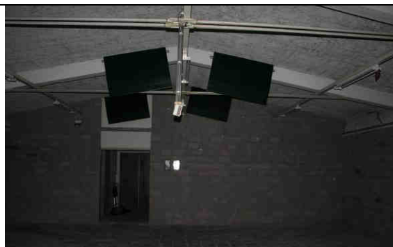
Gebouw V2 Heesch: vleermuiskasten en binnenmuren. Foto: Wesley Overman
