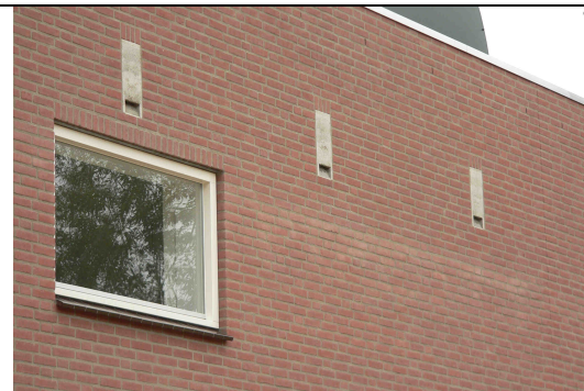
Heesch: inmetselfkasten in gevel gebouw W. Foto: Erik Korsten
