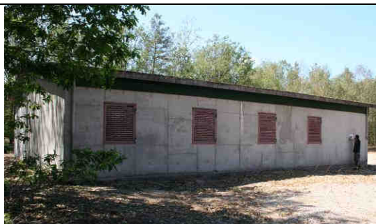
Gebouw V2 Heesch: boeiborden en toegang tot spouwmuren. Foto: Wesley Overman
