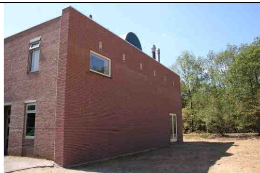
Heesch: gebouw W met inmetselfkasten. Foto: Wesley Overman.
