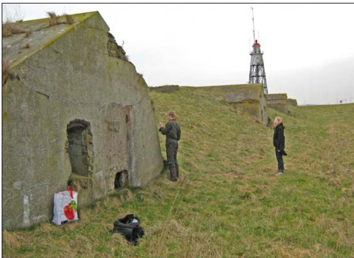
Afbeelding 9. De vier geschutsbunkers op het Vuurtoreneiland. Deze bunkers zijn in principe geschikt om te worden ingericht voor overwinterende vleermuizen. Foto: R.M. Koelman.
