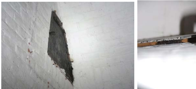
Figuur 12: De deels afgesloten kruitdampkanalen met dilatatievoegen op de 1 e verdieping, de speciale overwinteringsplekken van groepen gewone dwergvleermuizen.
