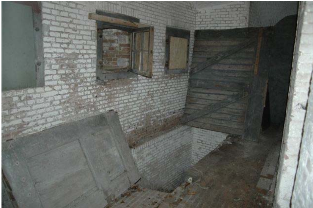
Figuur 14: De vleermuizeningang tot de kelder, openstaande luiken in kamer 15.
