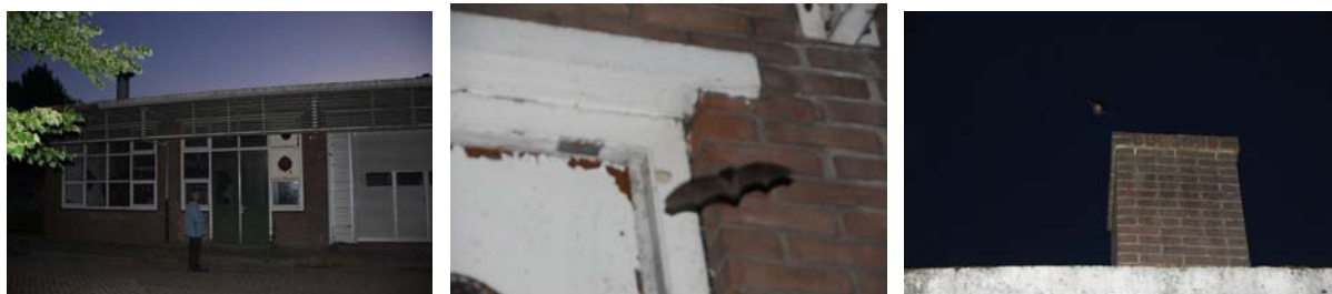
Figuur 16: De zomerverblijfplaats van gewone dwergvleermuizen in de muur en schoorsteen van loods B.
