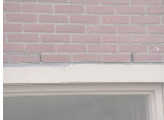
Open stootvoegen boven kozijn
