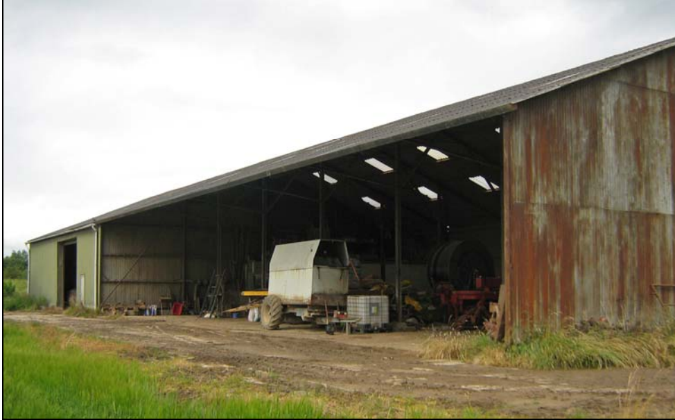
Afbeelding 3. De te slopen loods op locatie A. Foto: R.M. Koelman.
