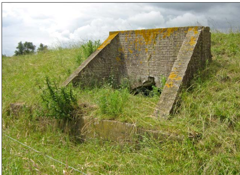
Afbeelding 11a. Sluisje in de dijk aan de westkant van Polder Moordplaat (coördinaten: X = 116.692 en Y = 417.148). Dit sluisje is in principe zeer geschikt om in te richten voor overwinterende vleermuizen. Mogelijk wordt het object al door overwinterende vleermuizen gebruikt. Foto: R.M. Koelman.
