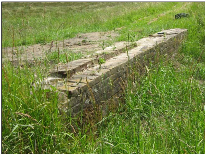
Afbeelding 12. Sluisje in de dijk aan de westkant van Polder Lepelaar (coördinaten: X = 116.619 en Y = 416.198). Dit sluisje is in beperkte mate geschikt om ingericht te worden voor overwinterende vleermuizen. Foto: R.M. Koelman.
