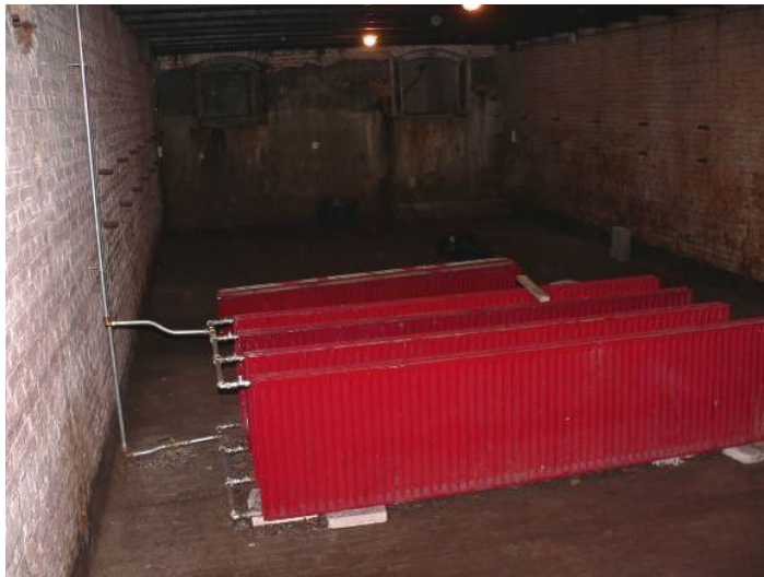
Het drogen/ start van droogstoken van de kelders van Fort Giessen (foto's E.Korsten)
