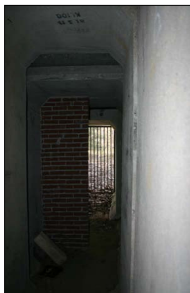
Foto 12. De 'Tunnel Stationsweg Herkenbosch' werd in 1990 gebouwd en was het eerste kunstmatige winterverblijf in Limburg. De 36 meter lange gang is opgebouwd uit betonelementen. Tot nu toe bleef de bezetting beperkt tot een enkele grootoorvleermuis. In 2006 is het object verder aangepast om de geschiktheid voor vleermuizen te vergroten. Foto's: Wouter Jansen.
