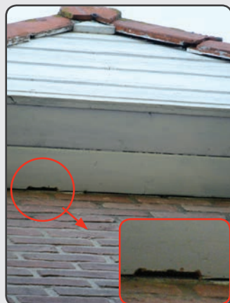
Twee invliegopeningen in dakrandbetimmering.
