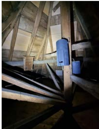
Foto 6 (links) | Er zijn invliegopeningen gemaakt van 2 cm hoog bij 7 cm breed rondom de torentjes. Foto 7 (midden) | Bolle en platte kasten zijn opgehangen in de torentjes. Foto 8 (rechts) | Houtvezelcementplaten zijn opgehangen als extra weggroipmogelijkheden in de torentjes. Onder de platen liggen keutels die duiden op gebruik van de platen.
