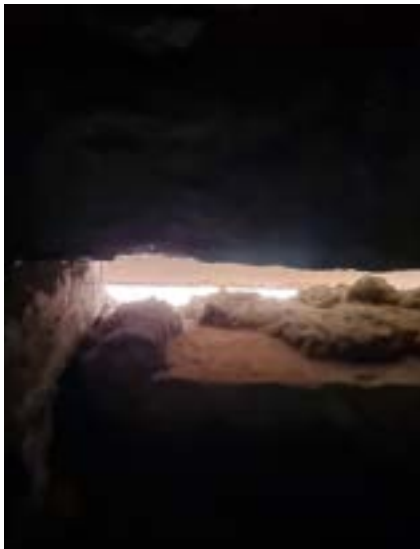
Foto 6 (links) | Er zijn invliegopeningen gemaakt van 2 cm hoog bij 7 cm breed rondom de torentjes. Foto 7 (midden) | Bolle en platte kasten zijn opgehangen in de torentjes. Foto 8 (rechts) | Houtvezelcementplaten zijn opgehangen als extra weggroipmogelijkheden in de torentjes. Onder de platen liggen keutels die duiden op gebruik van de platen.
