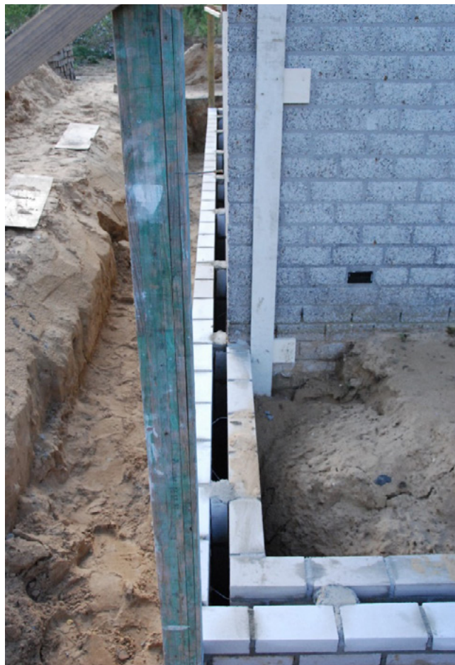
Figuur 2: Toevoegen extra spouwblad en portaal. Foto: Ruud Kaal
