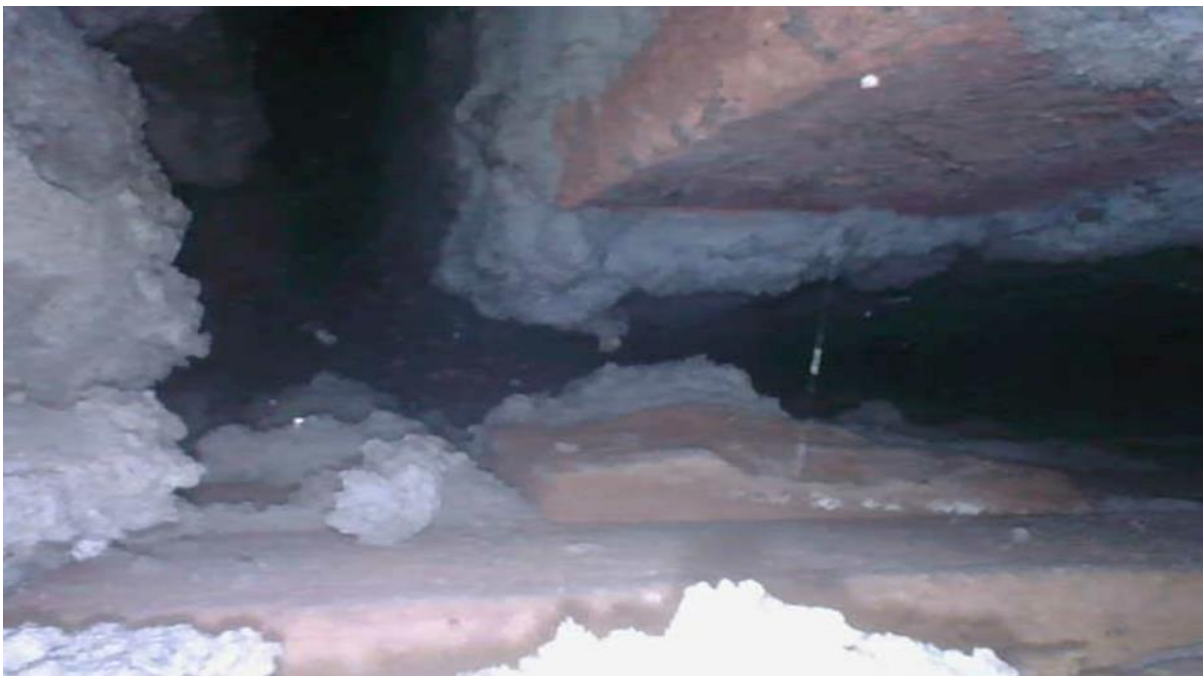
Figuur 1. Opname van een spouw met endoscoop. Aan de binnenzijde van een spouwmuur zijn vrijwel altijd uitgelopen klodders cement aanwezig. Daardoor is een spouw vaak onoverzichtelijk, waardoor onderzoek met een endoscoop via bestaande openingen in de regel een onvolledig beeld geeft van de aanwezigheid van vleermuizen.
