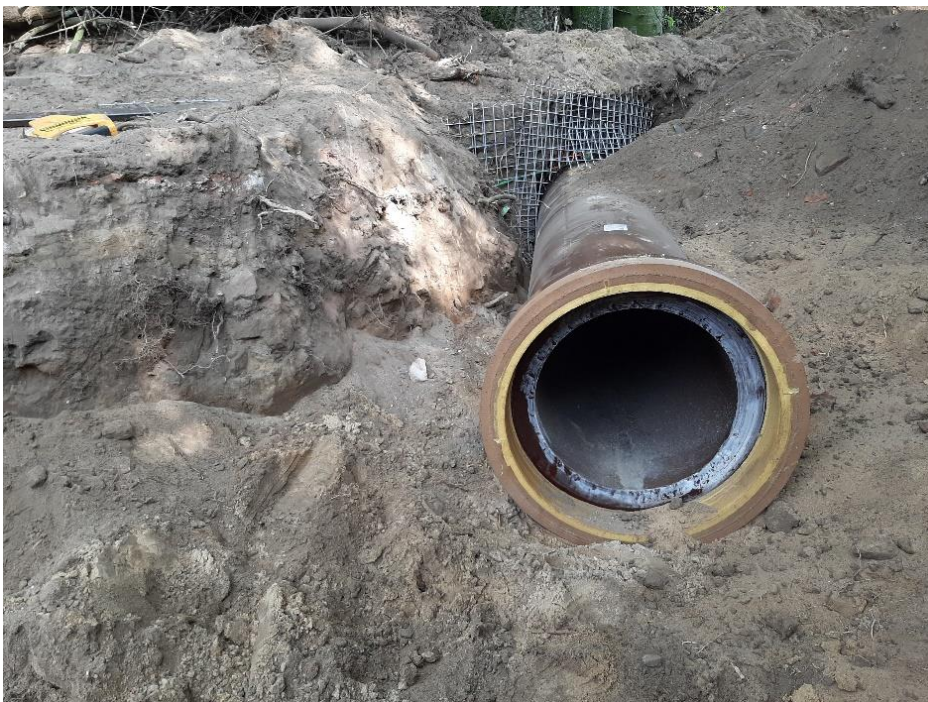
Figuur 6. De aangebrachte gresbuis (diameter 40 cm) onder het toegangspad.
