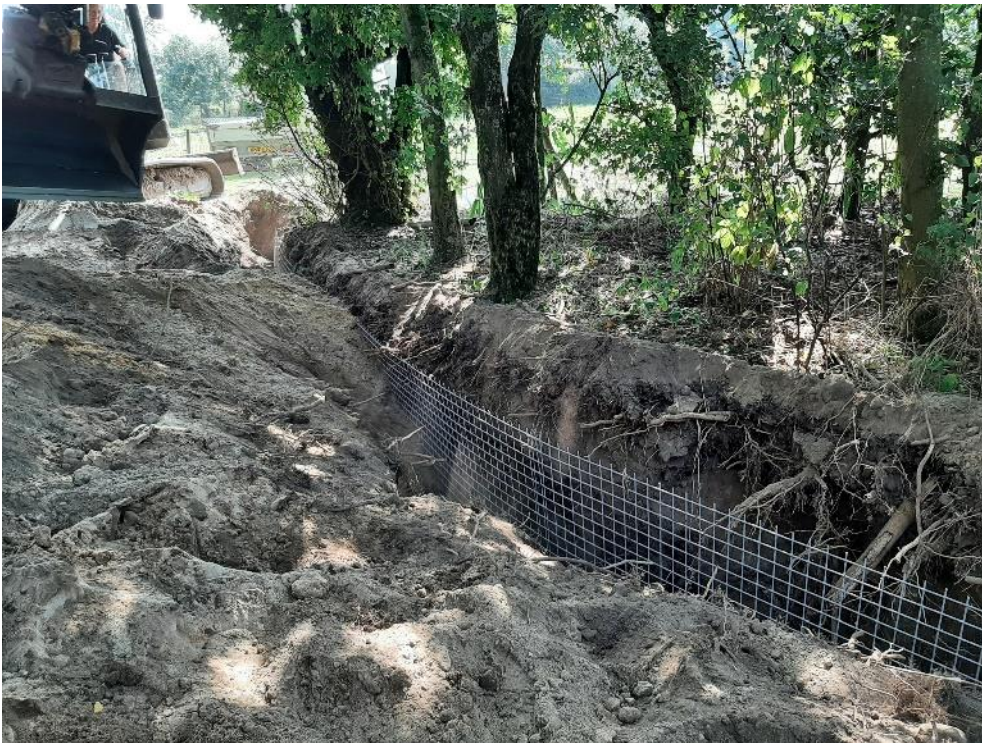
Figuur 4. De aangebrachte gaasmatten.
