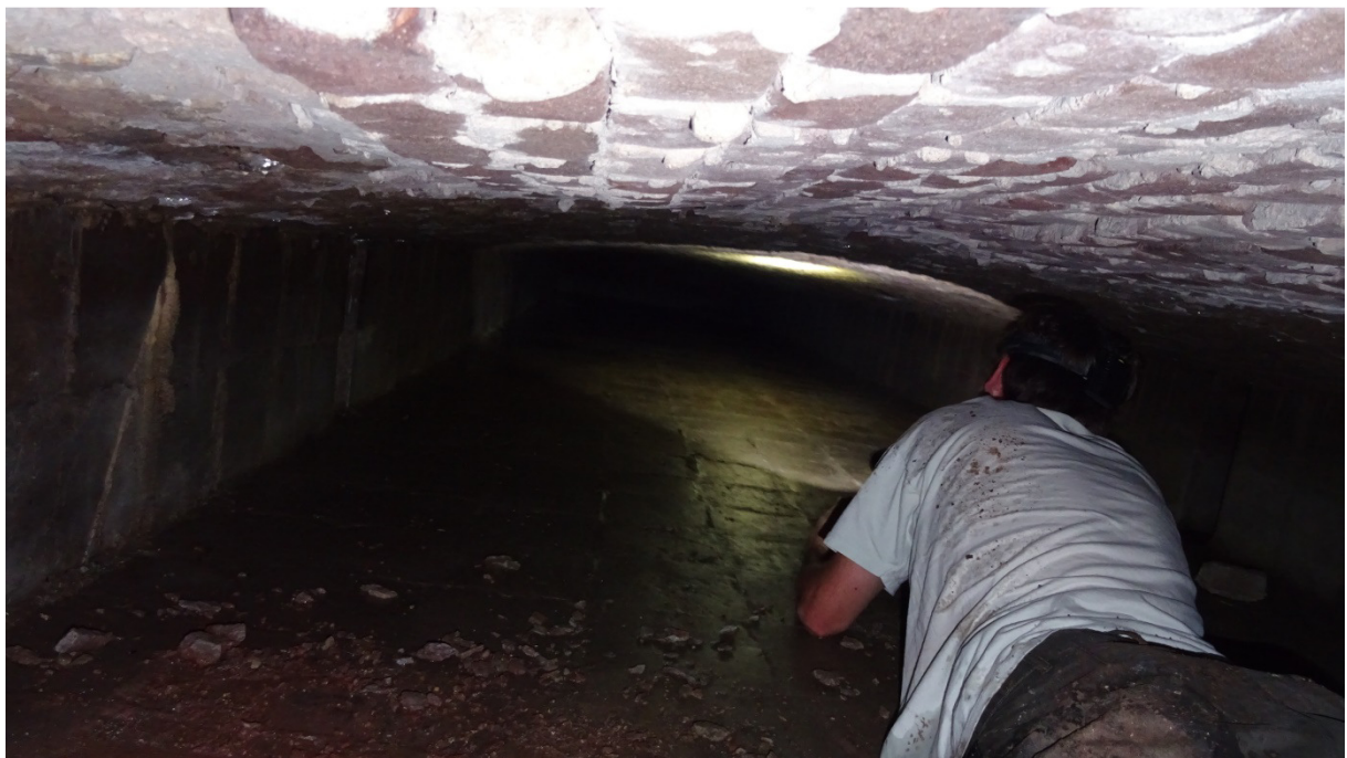
Figuur 1: beeld van de inspectie van de lage reinwaterkelders.
