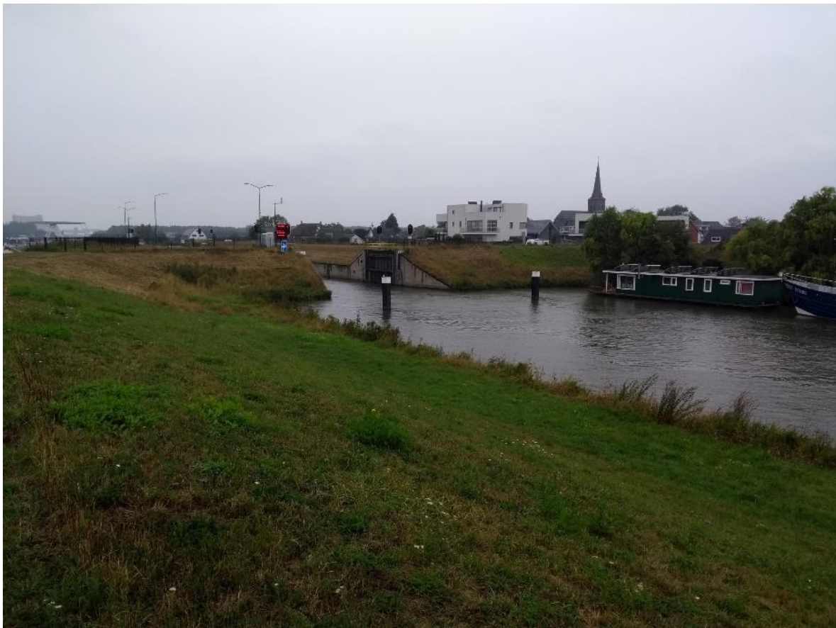
Foto 1. De primaire waterkering richting de sluis naar Oss.
