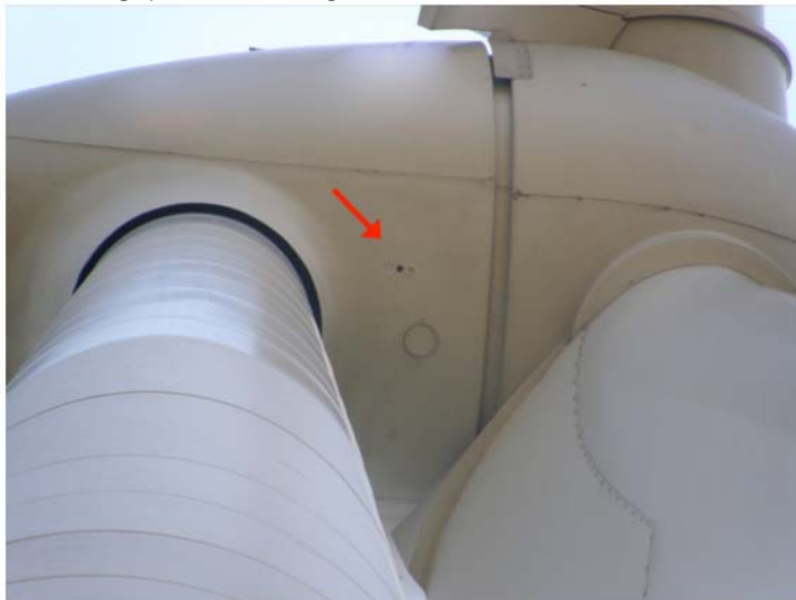
Abbildung 2 Außenansicht der Position der Aufnahmegeräte im Keller der WEA-Gondel
