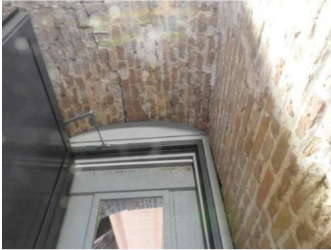
Figuur 22: De oude vleermuizendoorgang voor vleermuizen van het schip naar de toren. Na plaatsing van branddeur voor vleermuizen niet meer toegankelijk.
