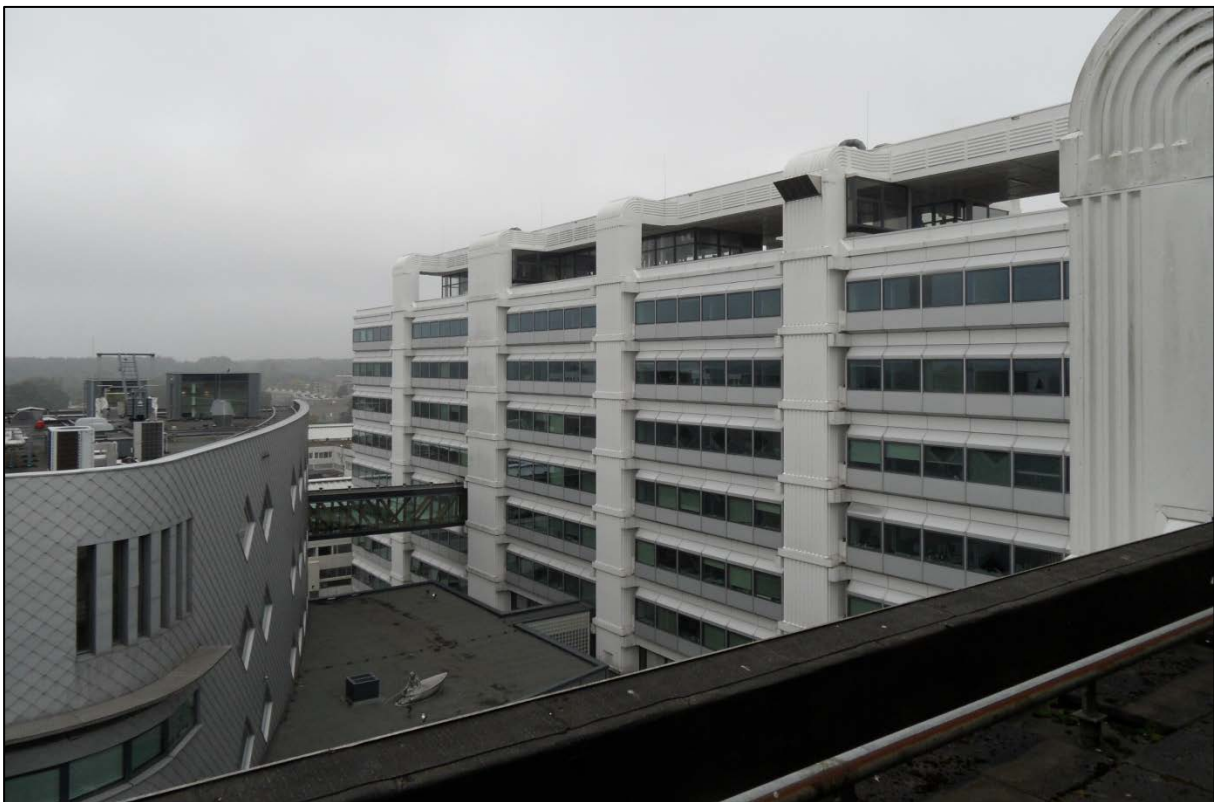
Figuur 4. Aanzicht vanaf het dak op de bebouwing van het projectgebied.
