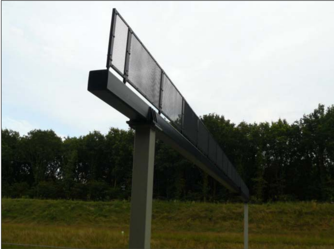
Figuur 7. Een voorbeeld van een geperforeerde hop -over van stalen platen geplaatst op een standaard verkeersportaal. Dit betreft een voorbeeld bij Gieten (Schut et al., 2013). Deze brug is echter niet goed aangesloten op de omgeving. Voor het plangebied bij Grubbenvorst wordt sterk aangeraden om het kunstwerk goed aan te laten sluiten op de groenstructuren in de omgeving.
