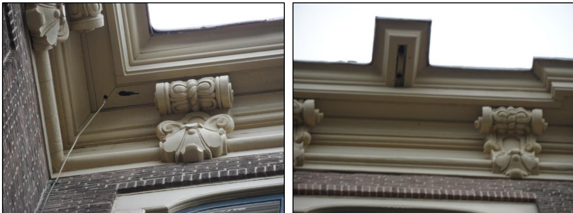
Figuur 7. Gat in overhangende houten dakrand en katrol in het zuidelijke deel van de bebouwing in het projectgebied.
