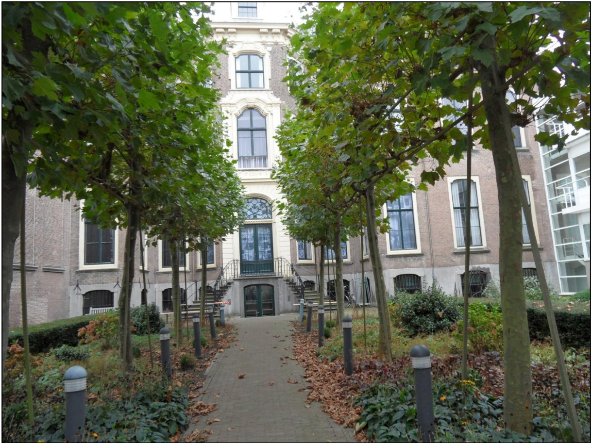
Figuur 3. Bebouwing ten zuiden van de Kazernestraat en een impressie van de tuin.
