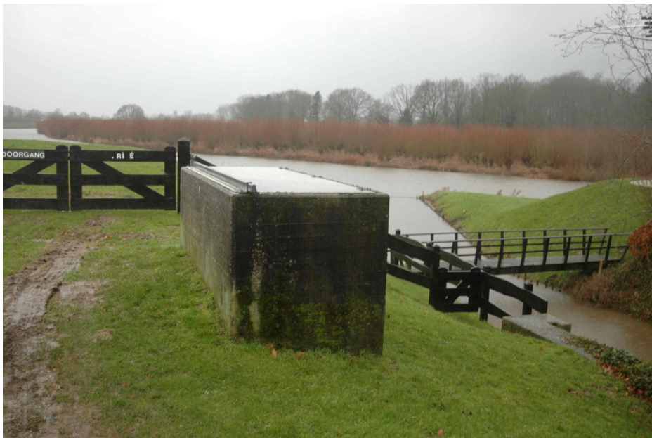
Figuur 3: De huidige dijkdoorlaat met schotkap.
